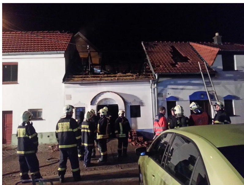
Obrázek 3 Požár vinného sklepa v Bořeticích (Langer, 2015)
