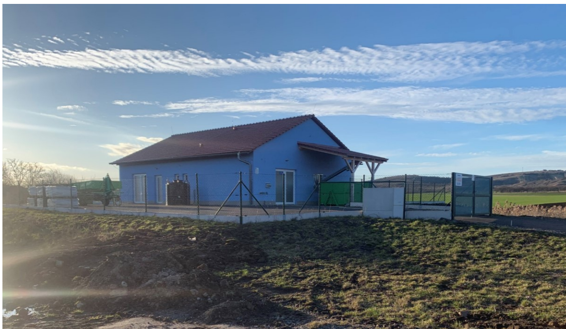
Obrázek 4 Čistírna odpadních vod (vlastní, 2024)
