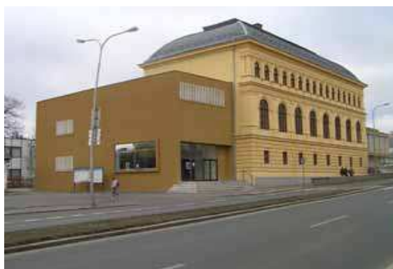
Obr. 4. Budova společenského domu [26]
