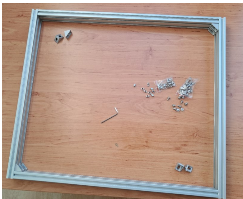
Obrázek 33: Stavba rámu z hliníkových profilů
