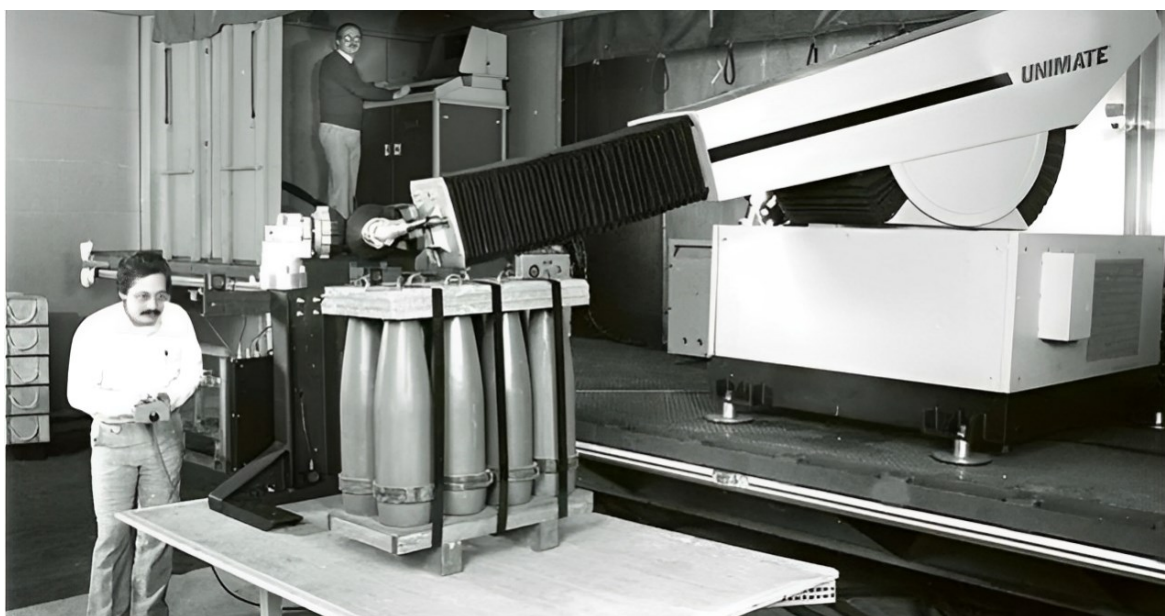
Obrázek 3 První průmyslový robot UNIMATE [18]
