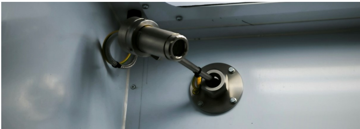
Obrázek 25 Čidlo detekce zhasnutí plamene [48]
