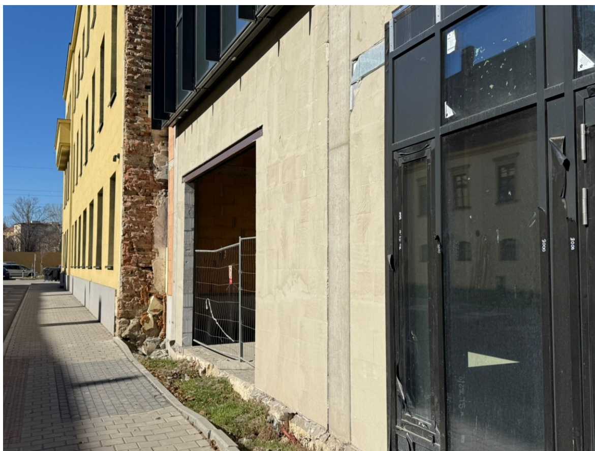
Obrázek 9 Perimetr areálu ukončen budovami
