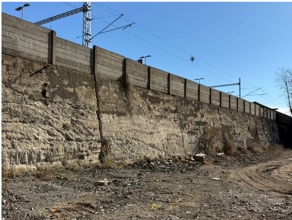
Obrázek 17 Betonový svah oddělující východní část a přilehlé nádraží
