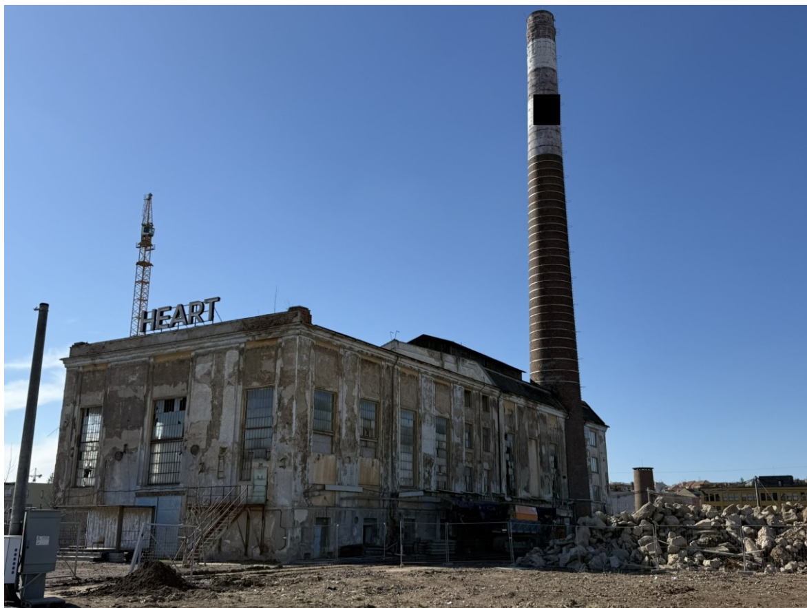
Obrázek 15 Poslední budova ve střední části areálu (před rekonstrukcí)
