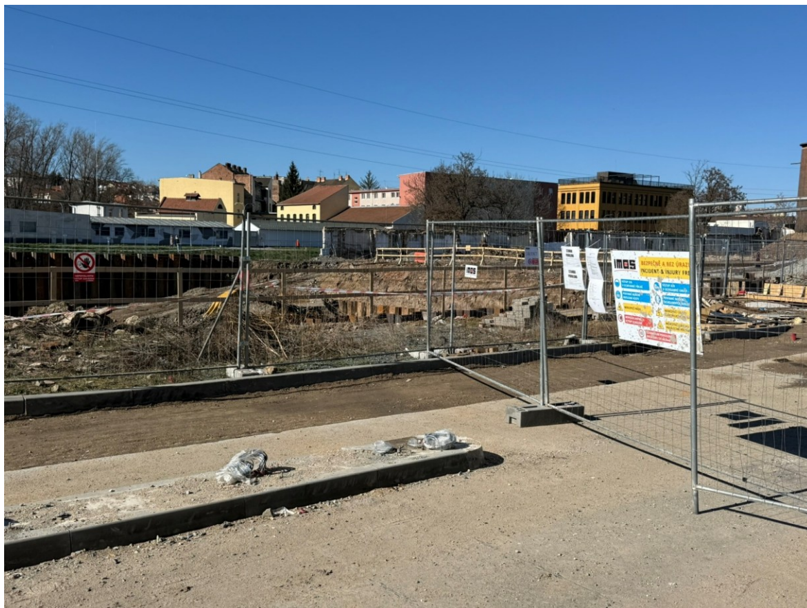
Obrázek 12 Aktuálně demontovaná automatická brána z důvodu probíhajících prací
