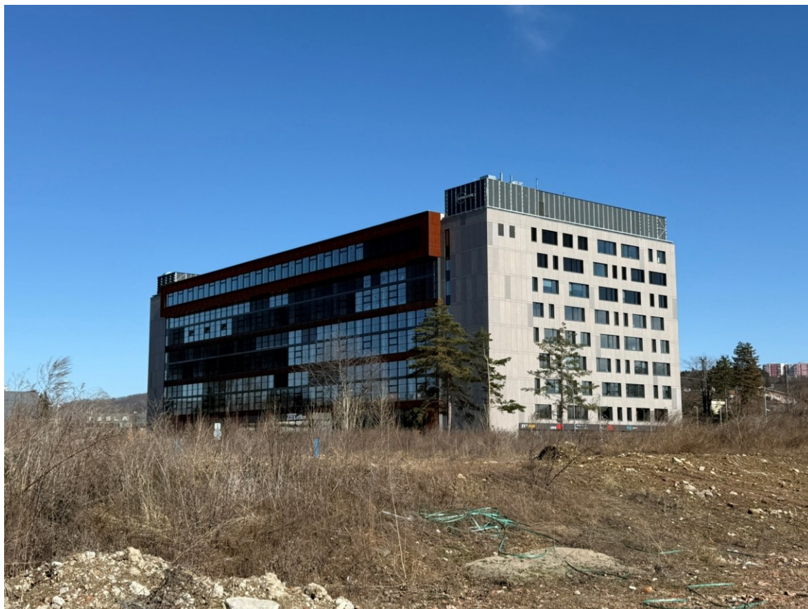
Obrázek 4 Opravená hlavní budova v severní části
