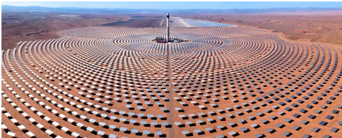
Obrázek 3 CSP elektrárna Noor Energy 1
