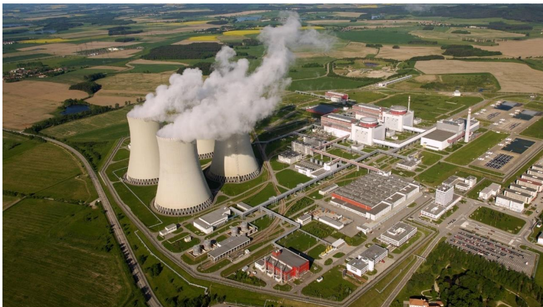
Obrázek 1 Jaderná elektrárna Temelín
