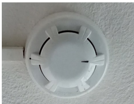
Obrázek 9 Požární hlásič
