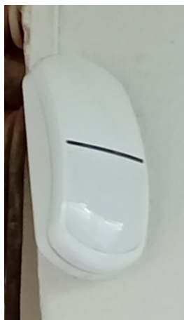
Obrázek 15 PIR detektor v rozhlase
