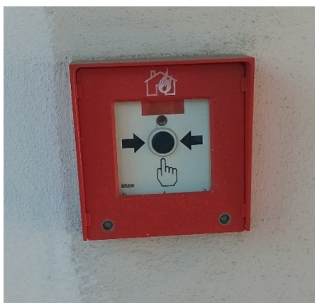
Obrázek 10 Tlačítkový hlásič požáru na východní tribuně
