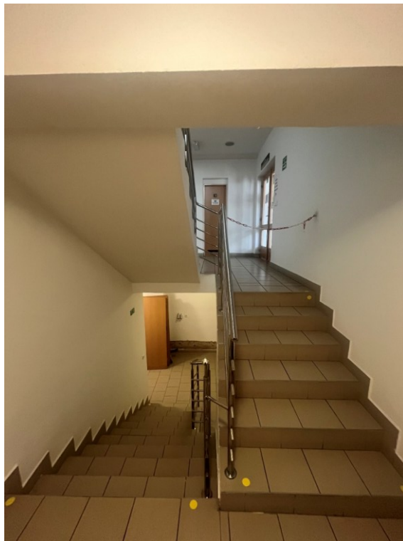
Obrázek 22 Vstup do suterénu zájmového objektu skrze hlavní schodiště
