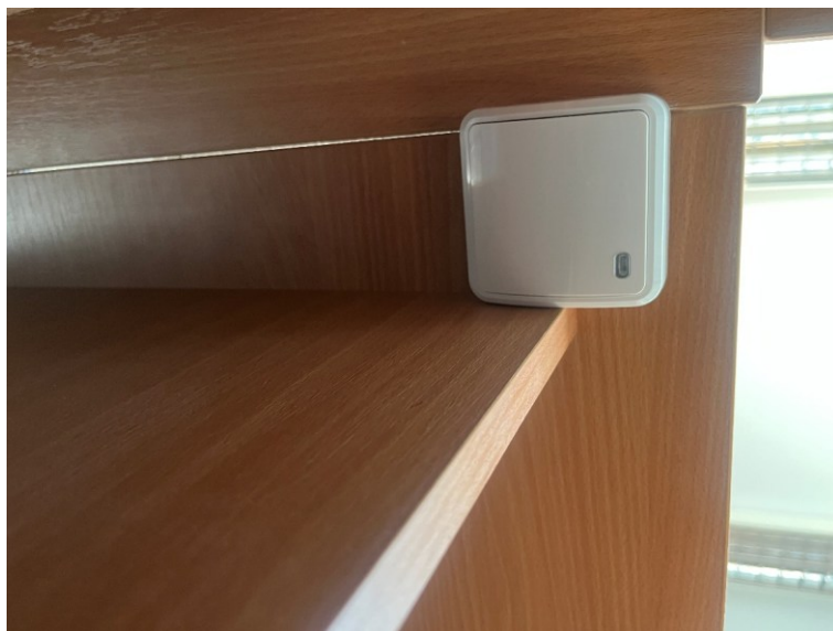
Obrázek 40 Tísňové tlačítko
