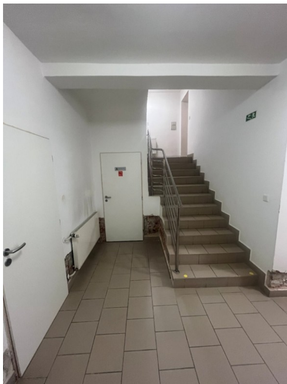
Obrázek 25 Sklep zájmového objektu 2
