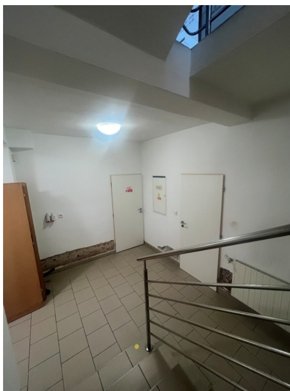
Obrázek 24 Sklep zájmového objektu 1
