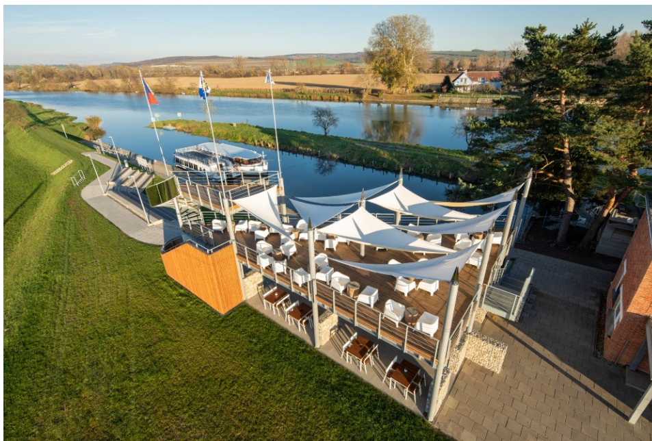
Obrázek 7 - Dokončená stavba vyhlídkové terasy
