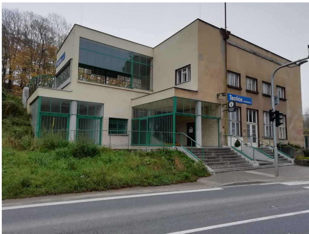
Obrázek 21: Fotka současného stavu budovy. (INFOCENTRUM HRANICE, 2024)
