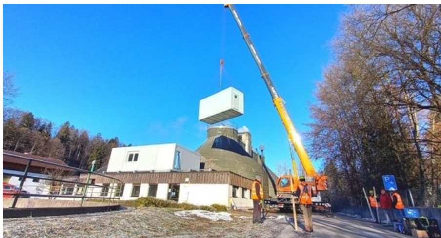
Obrázek 16 Sestavení obytných kontejnerů
