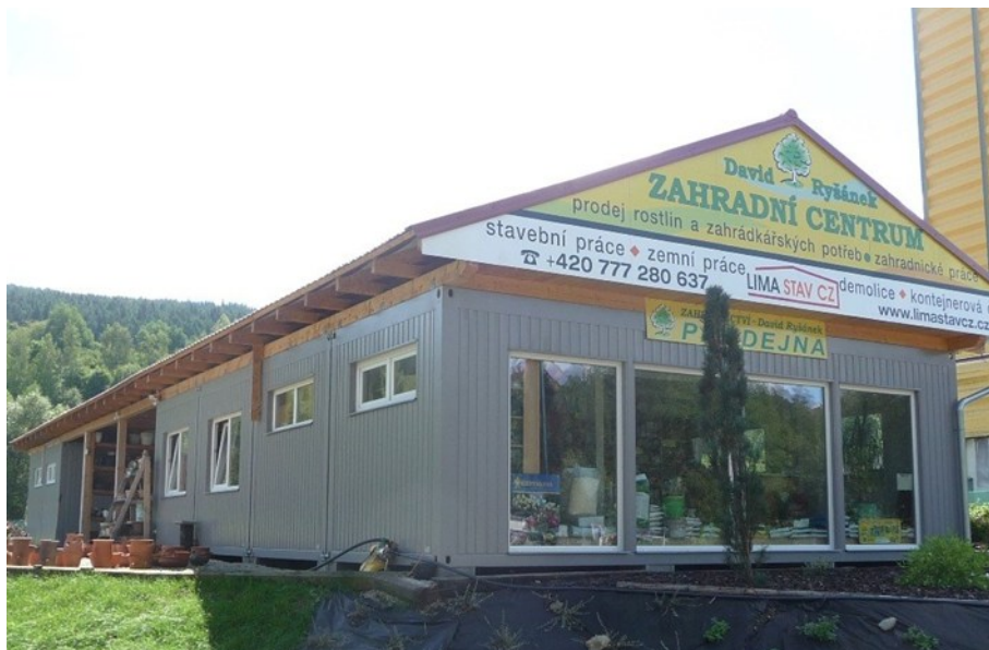
Obrázek 17 Přídavná střecha na modulární stavbu
