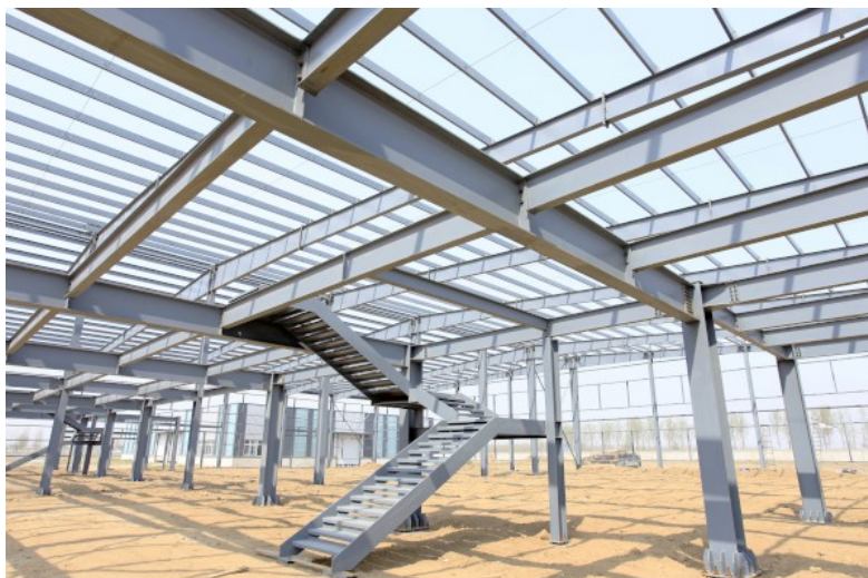
Obrázek 12 Svařené ocelové konstrukce
