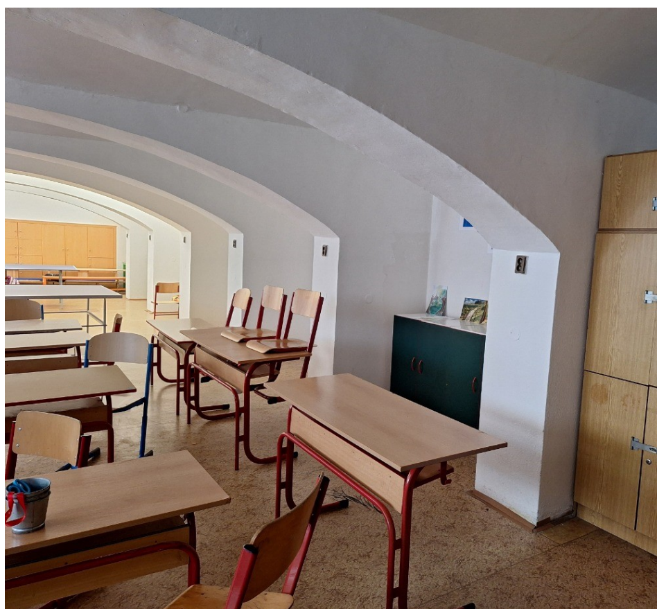
Obrázek: 7: současný stav učebny
