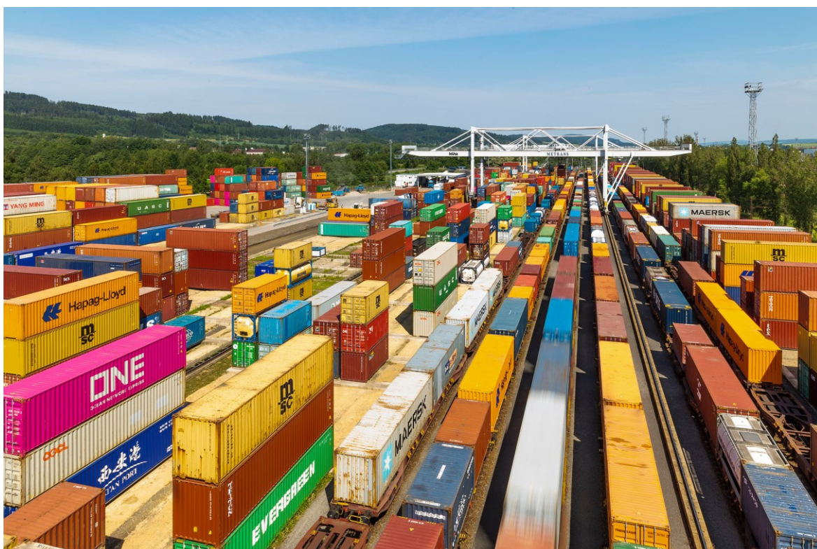
Obrázek 7 Překladiště Česká Třebová
