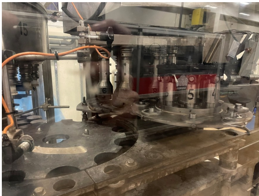
Obrázek 18 Přítlačný talíř zdroj: vlastní fotografie
