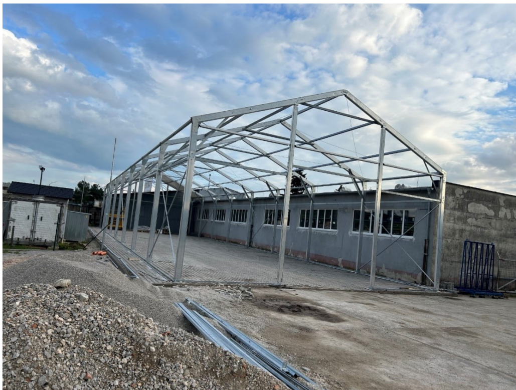
Obrázok 12 Výstavba nového skladu (Interné materiály)
