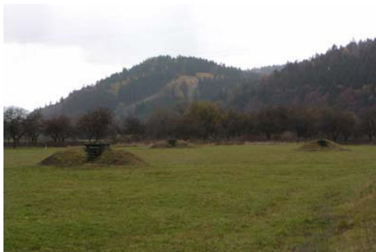
Obrázek 6 - Čerpací stanice Vsetín – Ohrada (prameniště)
