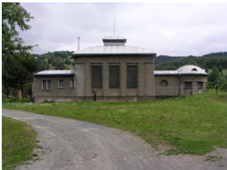
Obrázek 5 - Čerpací stanice Vsetín - Ohrada
