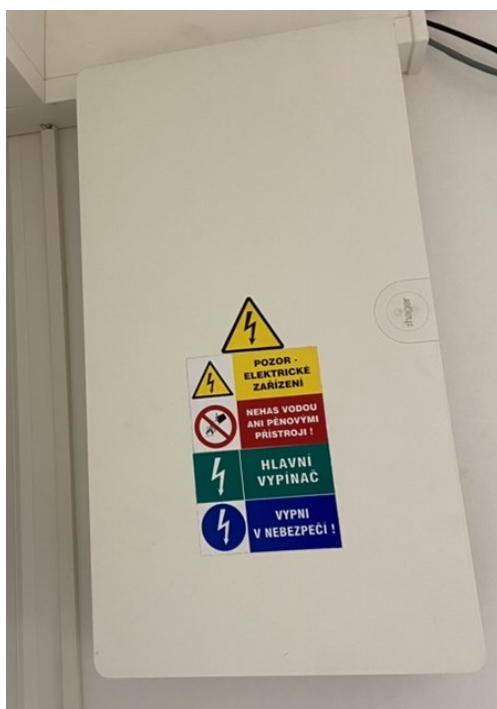
Obrázek 8 – Hlavní vypínač a bezpečnostní značky
