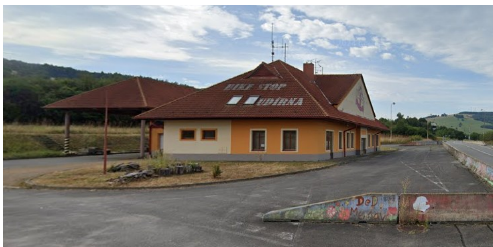
Obrázek 2 Budova hraničního přechodu
