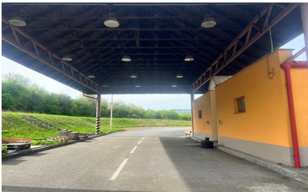
Obrázek 3 Budova hraničního přechodu
