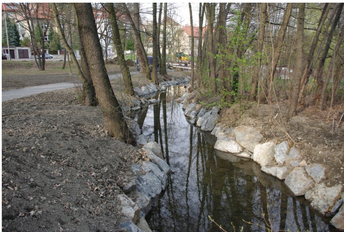
Obrázek 5 Stabilizace koryta Motolského potoka
