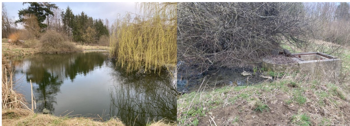
Obrázek 33 Zikmundov – celkový pohled na nádrž (vlevo) a výpustní zařízení s porostem (vpravo)
