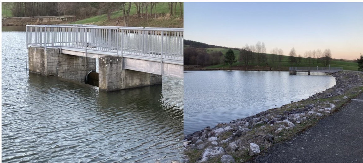
Obrázek 32 Pohled na objekt spodní výpusti (vlevo) a celkový záběr hráze se zpevněným návodním lícem a přístupovou komunikací (vlevo)
