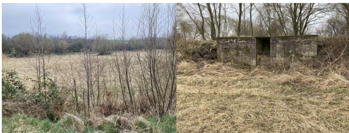
Obrázek 34 Jalubí – suchý retenční prostor (vlevo) a výpustní objekt s propustkem (vpravo)
