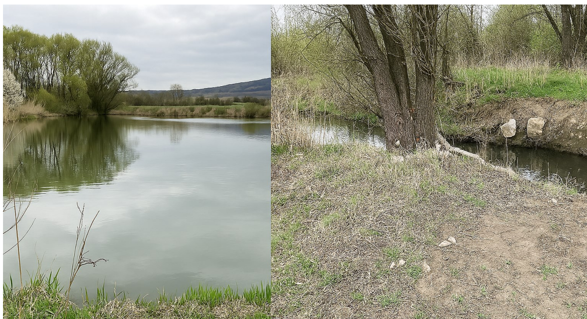
Obrázek 40 Ordějov – celkový pohled na hladinu (vlevo) a odtokový objekt s navazujícím korytem (vpravo)
