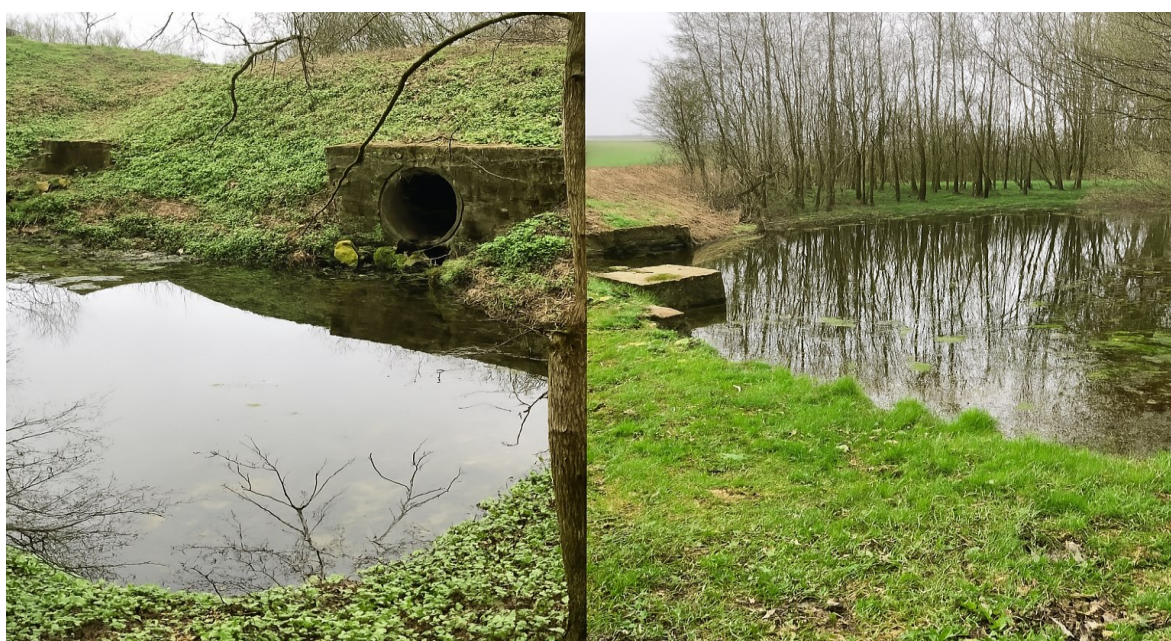
Obrázek 35 Nádrž Kopaniny – výpustný objekt (vlevo) a vodní plocha s porostem (vlevo)
