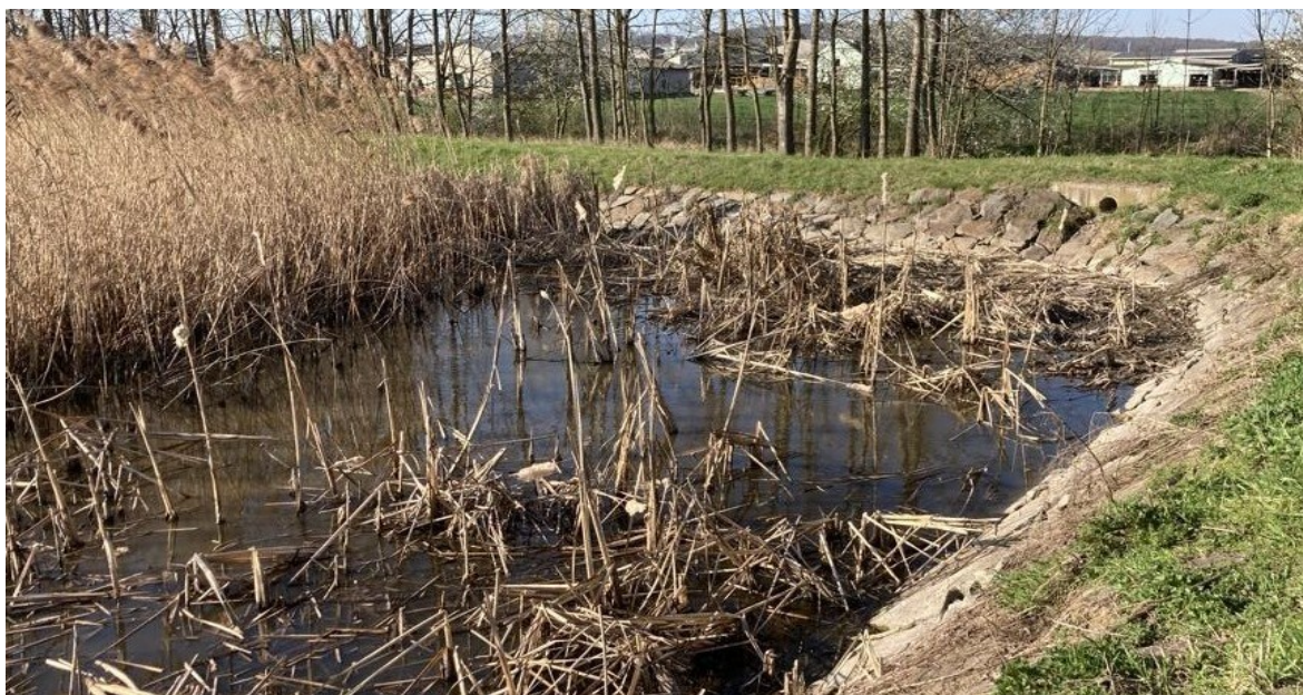
Obrázek 29 Bezpečnostní přeliv nádrže Roštění s výpustí do Pacetluckého potoka
