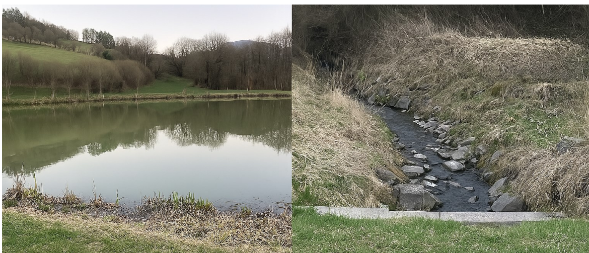
Obrázek 39 Klášťov – pohled na vodní plochu (vlevo) a odtokový objekt (vpravo)
