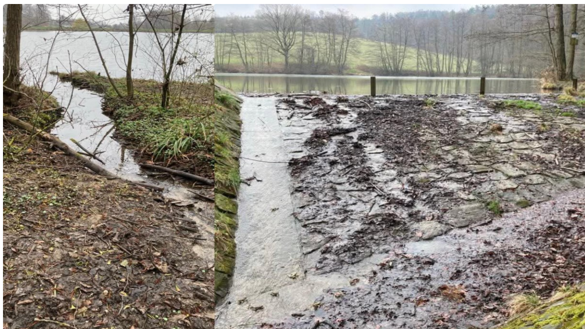
Obrázek 23 Prítokový úsek nádrže Lubná (vlevo) a bezpečnostní přeliv s vývarem (vpravo)
