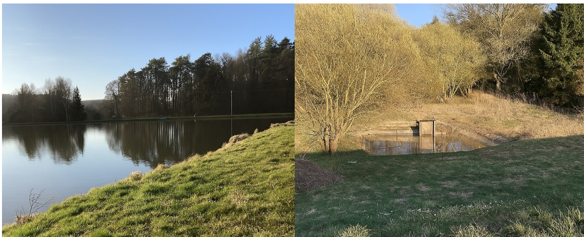
Obrázek 38 Ostratky – pohled na vodní plochu (vlevo) a detail výpustního objektu v zázemí hráze (vpravo)
