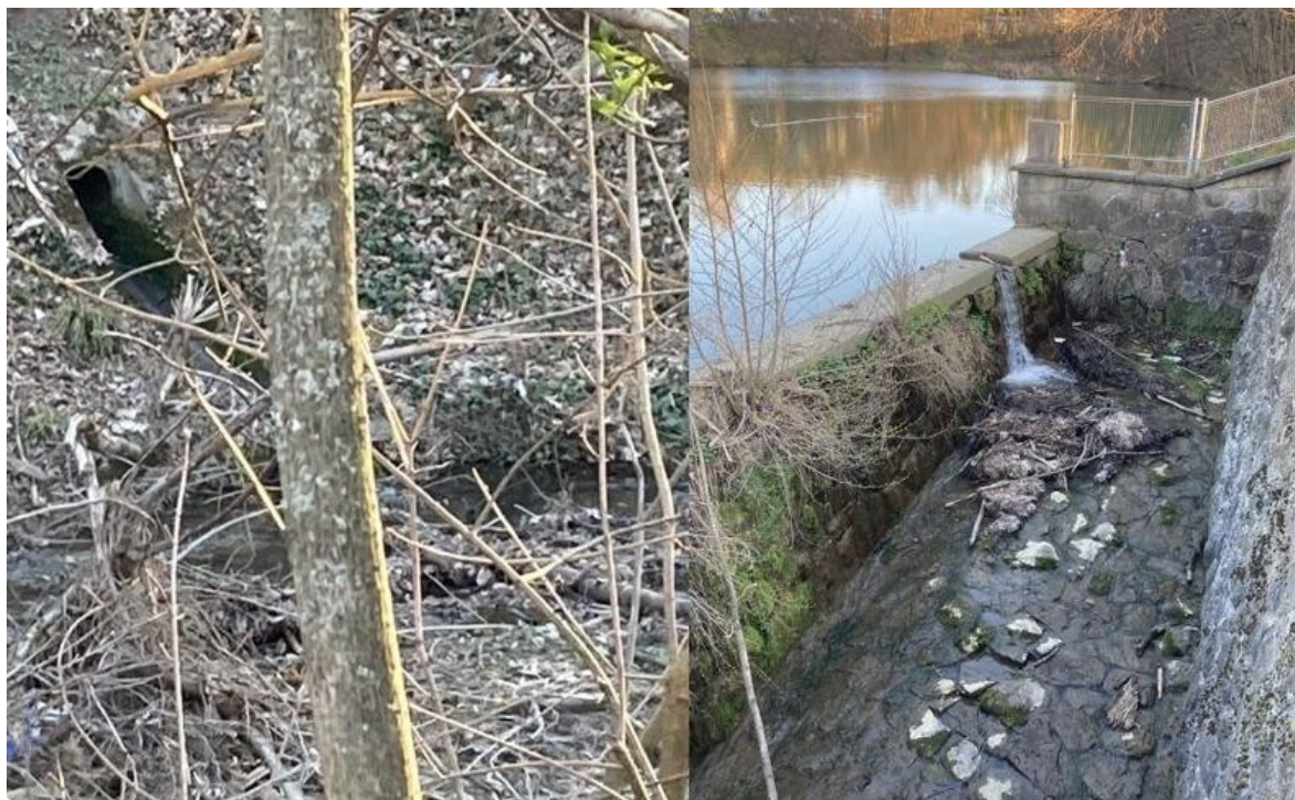
Obrázek 31 Vyústění do Kudlovského potoka pod hrází (vlevo) a pohled na odpadní koryto s výtokovým objektem (vpravo)
