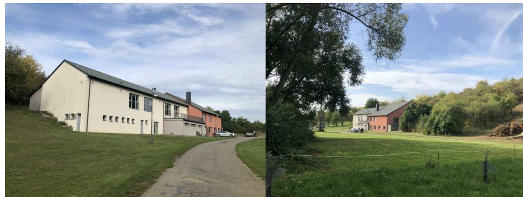
Obr. 16 Pohled na kulturní dům (zdroj: vlastní)
