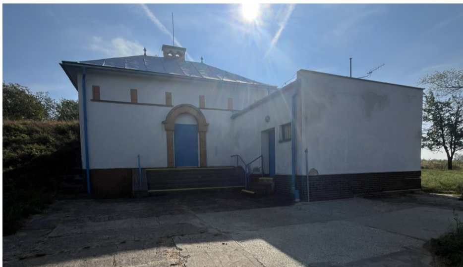
Obrázek 3 Objekt Mařatice horní vodojem a čerpací stanice
