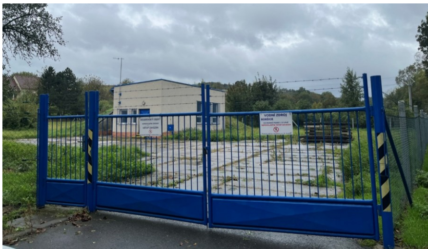
Obrázek 4 Objekt Boršice u Buchlovic čerpací stanice
