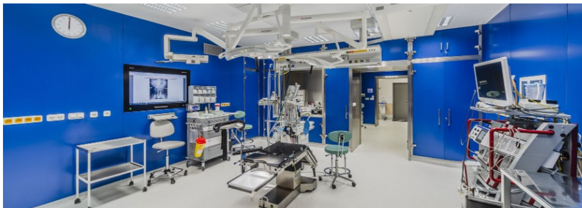
Obrázek 9 - Modulární sálkový systém vybavený sprinklerovým systémem (MedSol, 2025).
