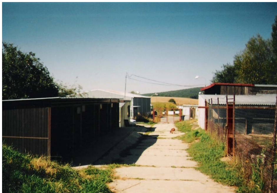
Obrázek č. 4: Nevyhovující prostory v útulku na Suchém dole
