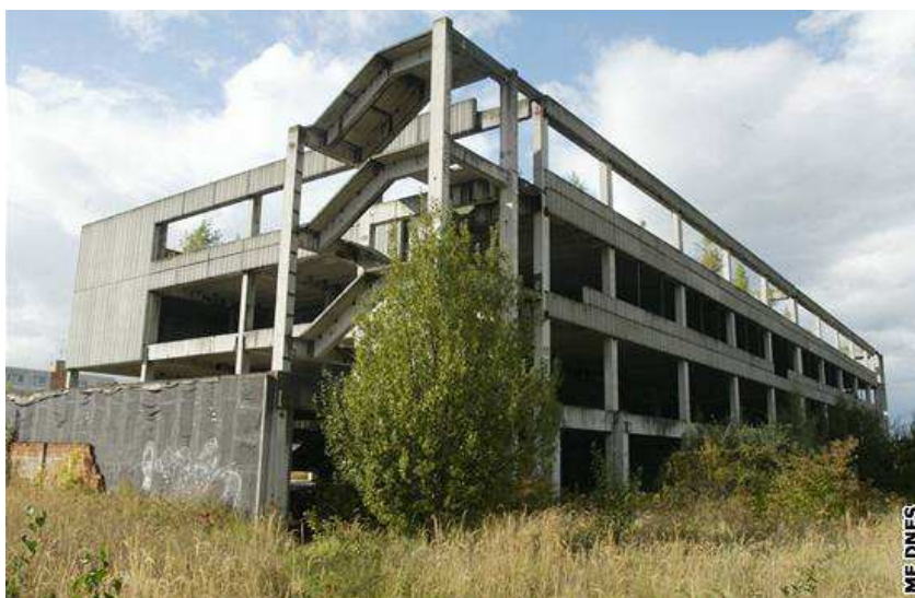
Obr. 6. – Rozestavěné obchodní centrum Jižní Svahy (Zdroj: MF Dnes)
