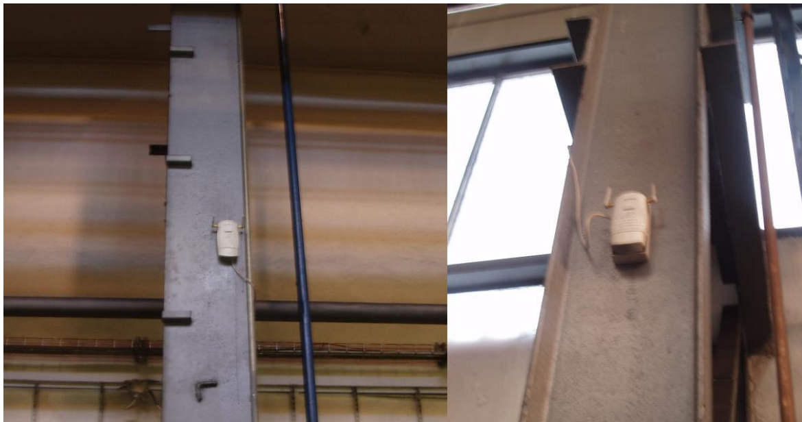
Obr. 40 Namontovaná AP na kovových konstrukcích haly
