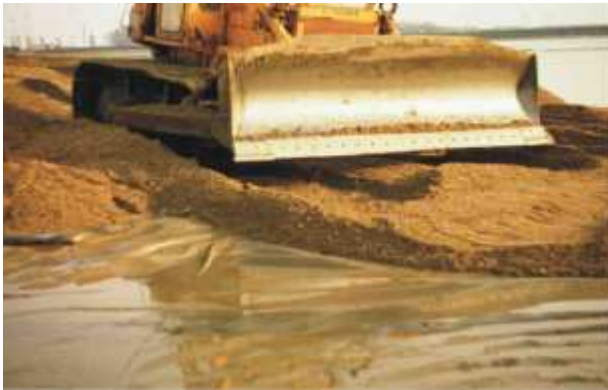
Obr. 11. Využití geotextilií – zpevnění, separace, filtrace, drenáž, antieroze [11]
