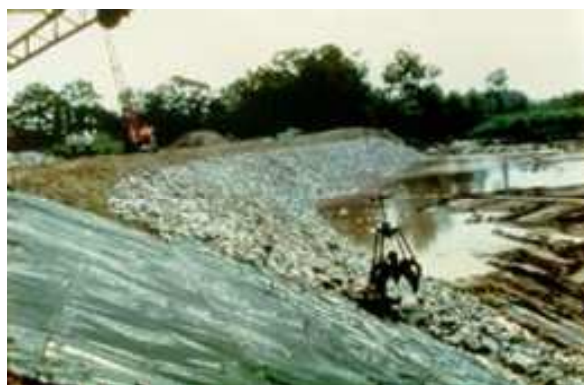
Obr. 16. Geotextilie – ochrana břehů [11]
