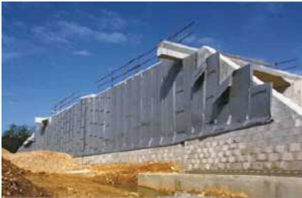
Obr. 12. Využití geotextilií – zpevnění [11]
