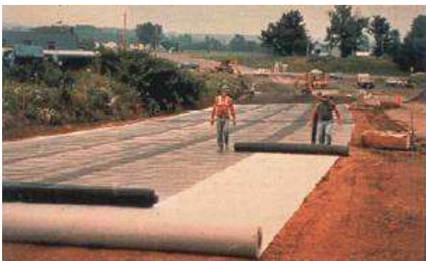
Obr. 13. Využití geotextilií – zpevnění, separace, filtrace, drenáž, antieroze [11]
