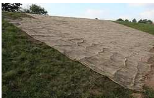
Obr. 7. Netkaná geotextilie k ochraně půdy proti erozi [26]
