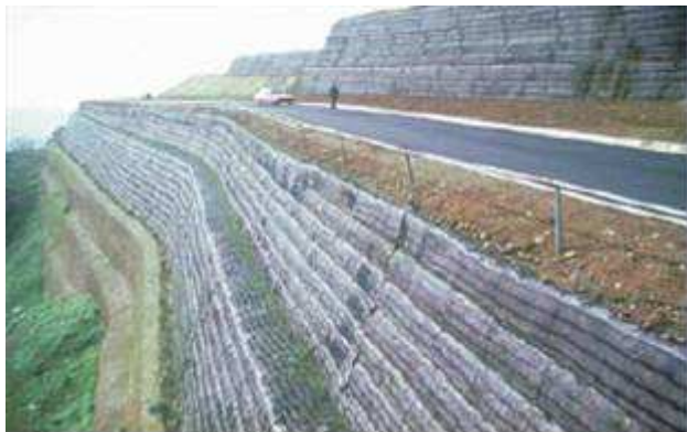
Obr. 14. Využití geotextilií – antieroze [11]
