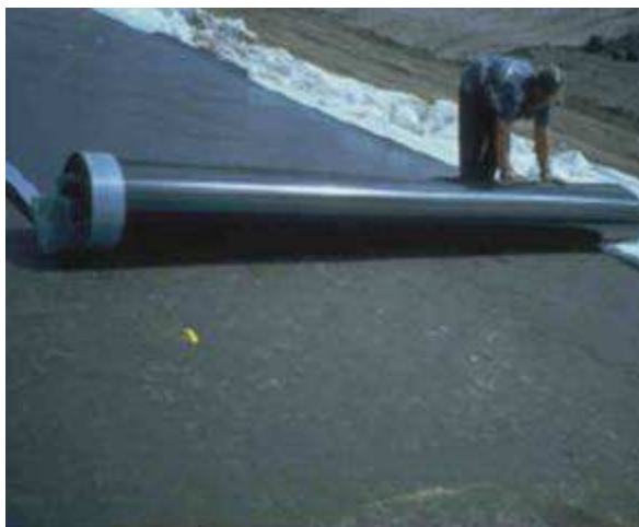
Obr. 15. Geotextilie – budování skládek pro nebezpečné odpady [11]
