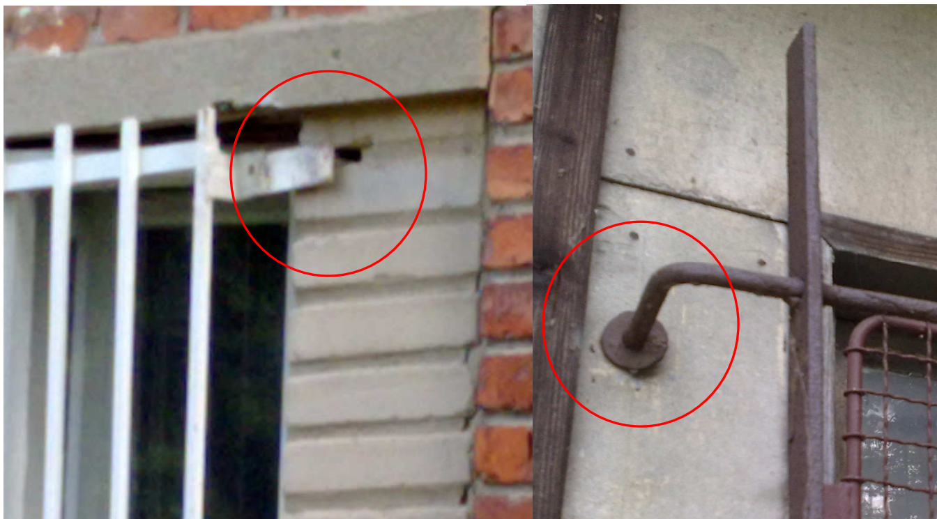
Obrázek č.7: Katastrofální usazení vnějších mříží, FOTO: Vladislav Adam
