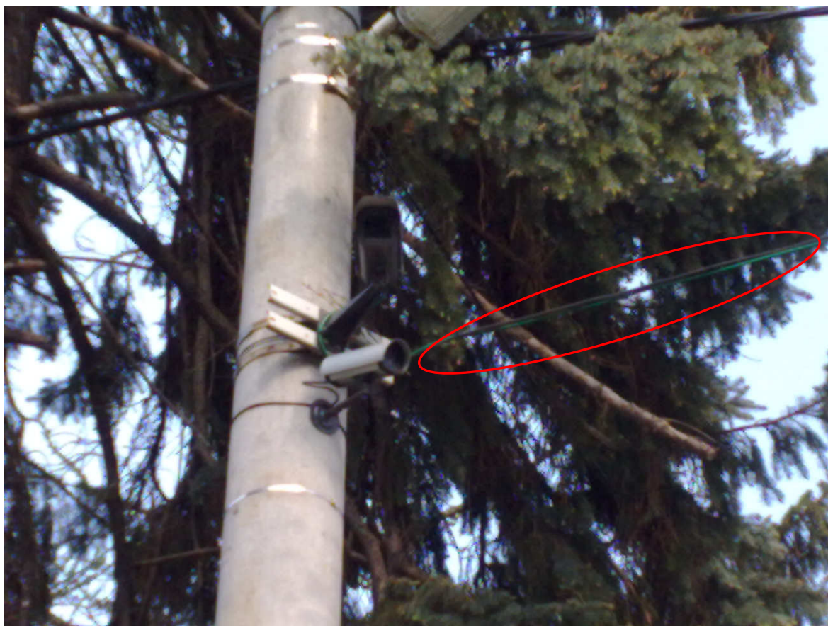
Obrázek č.11: Nechráněná přenosová cesta kamerového systému, FOTO: Vladislav Adam
