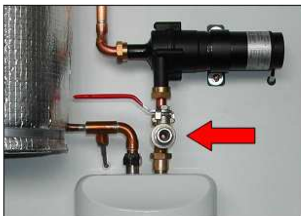
Obr. 3. Ventil pro napouštění a vypouštění vody
